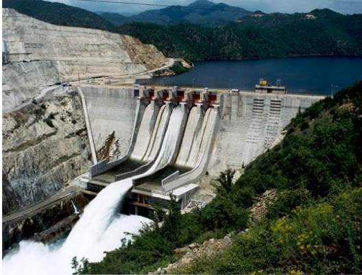
Planatovryssi Barajı (Yunanistan)
